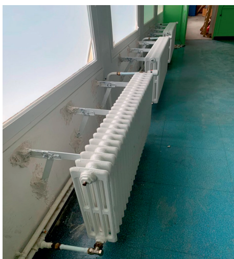
Repositionnement des radiateurs après adaptation du réseau de chauffage
