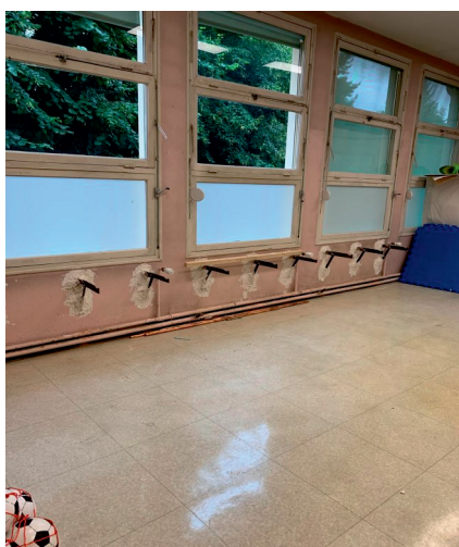
Adaptation des fixations des radiateurs
