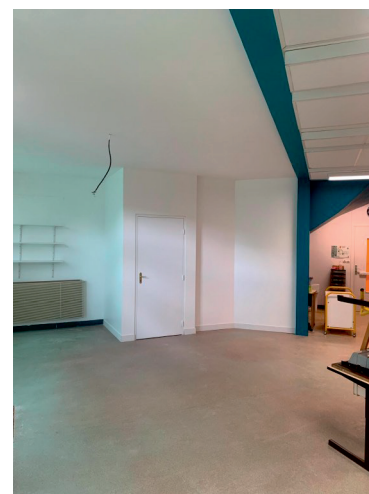
Faux plafond créé dans la classe de maternelle pour réduire le volume de chauffe de la pièce.
