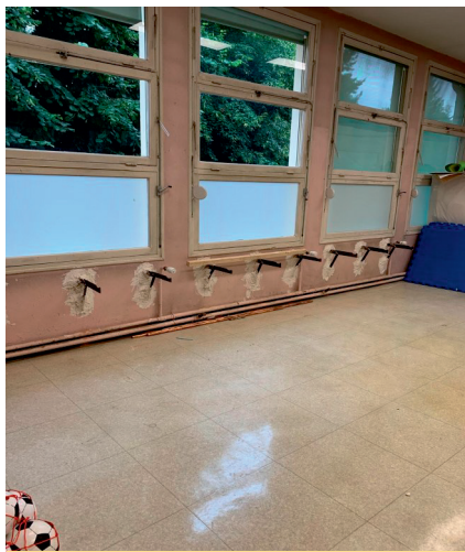
Adaptation des fixations des radiateurs
