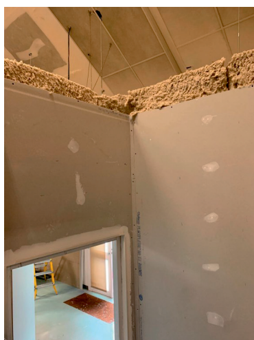
Mise en place de l'isolation dans la mezzanine de la classe de maternelle
