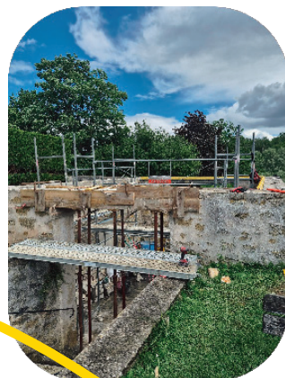
Raccordement de la source aux eaux pluviales chemin du prieuré
