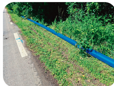
Assemblage de tronçons de tuyau pour constituer une longueur finale de 180 à 200 m
