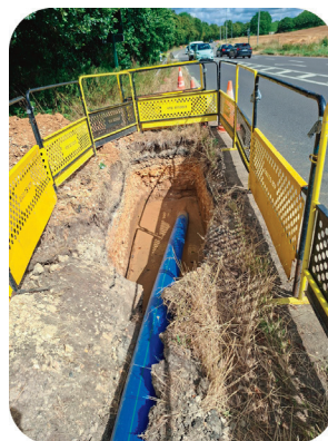
Acheminement du conduit par section de 180 à 200 m effectué avec le tunnelier en marche inverse au forage
