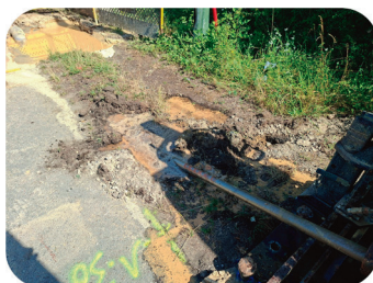
Forage d'une ligne de 180 à 200 m par ajout successif de cannes
